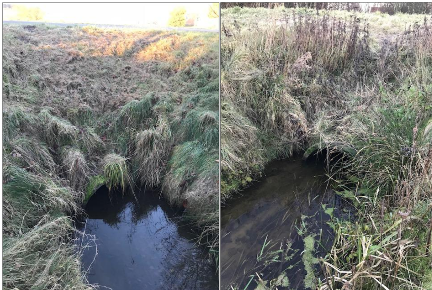
Fotos, taget af Skive Kommune, der viser den eksisterende rørbrø under Flyndersøvej ved henholdsvis ind- og udløb.
