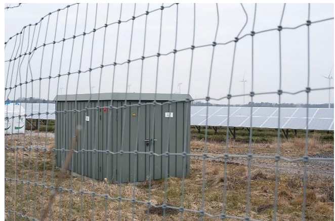
Figur 5: Eksempel på teknikbygning til transformere
